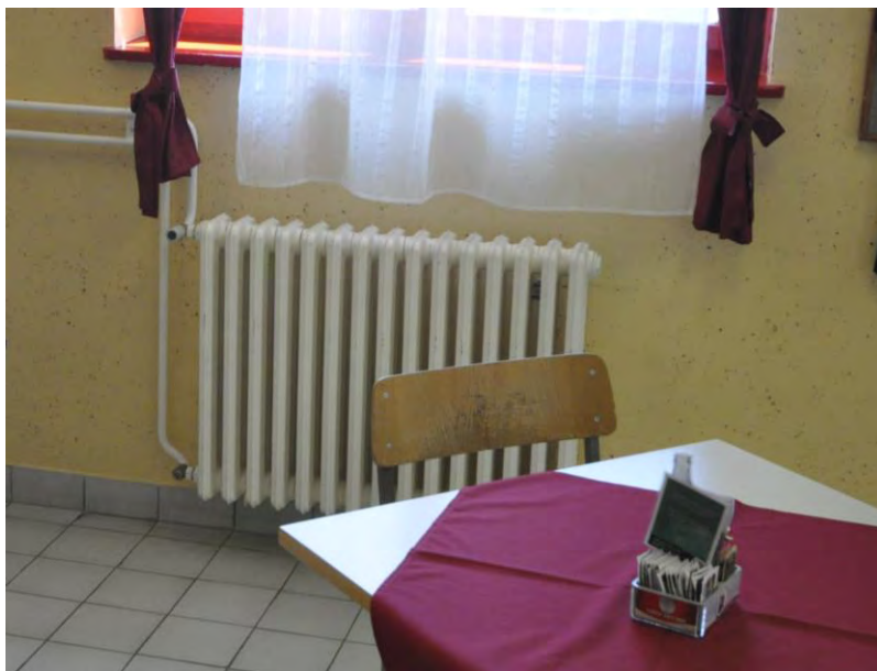
Slika 13: Fotografija tipičnih grelnih teles na objektu. Vir: Lastni arhiv pridobljen na dan ogleda.
